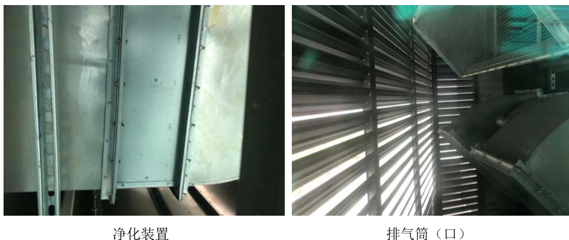
图4-1 净化装置及排气筒（口）现状
